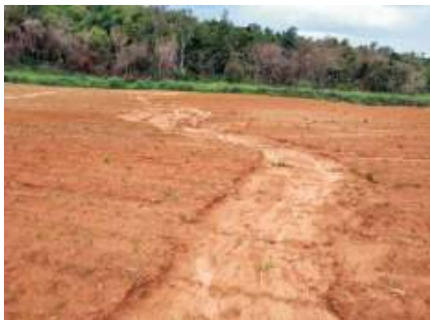
Figura 5 – Início do processo erosivo: sulcos superficiais
