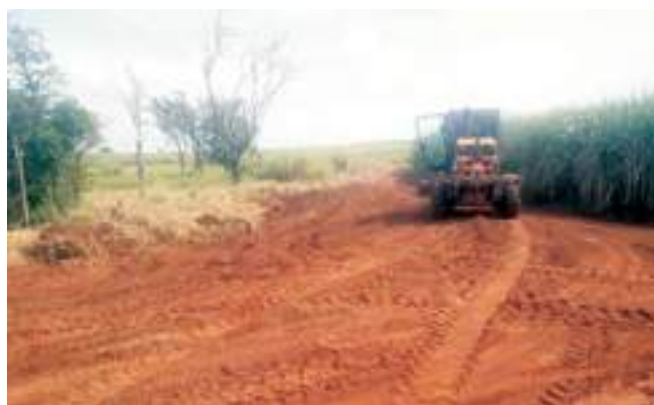
Figura 13 – Raspagem, feita mecanicamente, do material combustível
